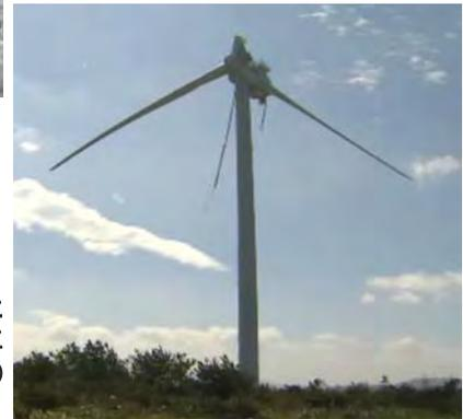
2016年の台風18号の強風(40m/s)によって壊れた5MW風車(韓国チェジュ島)
